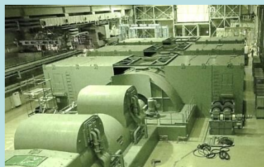
○ 2号機主タービン・発電機解体（タービン建屋内）
