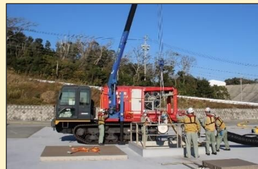
可搬型注水設備操作訓練
