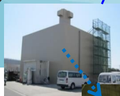
除熱機能強化対策： 緊急時海水取水設備
