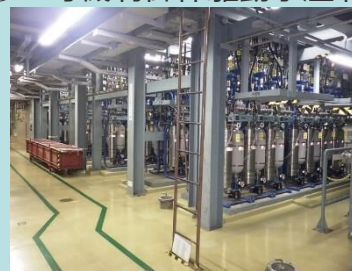
○ 2号機制御棒駆動水圧制御ユニット解体（原子炉建屋内）
