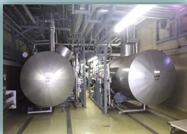
○ 1号機低圧給水加熱器解体（タービン建屋内）
