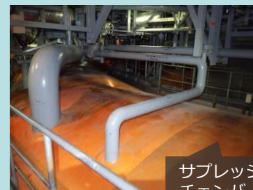
○ 2号機サプレッションチェンバ上部の配管撤去（原子炉建屋内）
