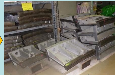
○ 2号機制御棒駆動水圧制御ユニット解体（原子炉建屋内）
