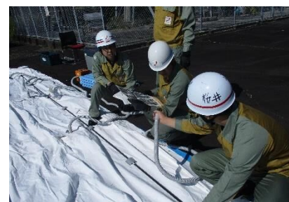
拠点の設営作業
