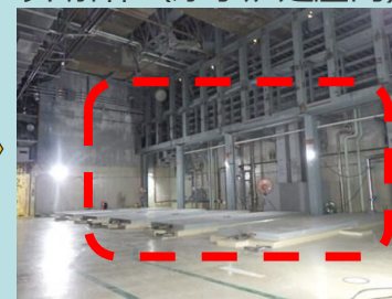
○ 2号機制御棒駆動水圧制御ユニット解体（原子炉建屋内）
