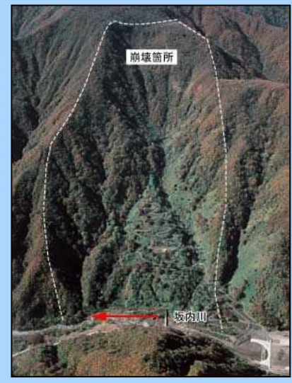
◀ 明治 28 年ナンノ谷大崩壊 揖斐川町坂内 (中部地方整備局ホームページ)
