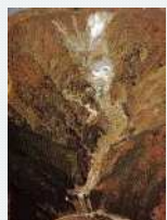
根尾白谷山腹工 本巣市根尾 (中部地方整備局ホームページ)
