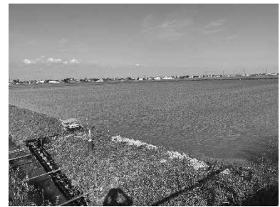
水田魚道の設置の様子
