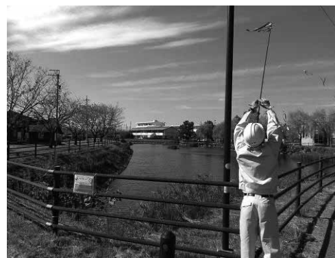
ため池の鳥よけ設置作業
