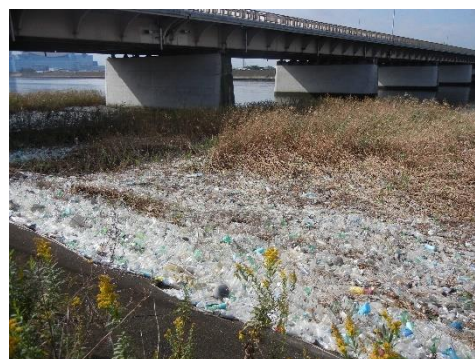
河川敷に散乱したプラスチックごみ
