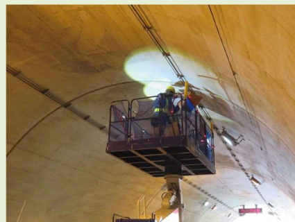
打保神岡停車場線 伊西トンネル
