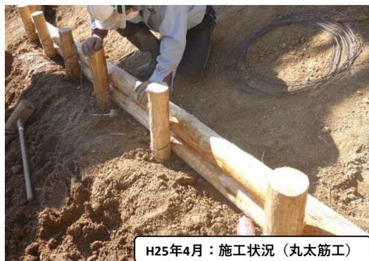
H25年4月：施工状況（丸太筋工）
