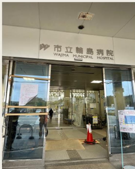
隆起により正面玄関に段差 ドアに補強テープ
