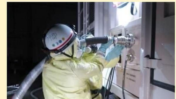
タイベックスーツを着用した夜間訓練（窒素供給車両への電源接続）
