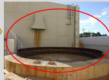
○浜岡1号機非常用ディーゼル発電機解体（原子炉建屋内）
