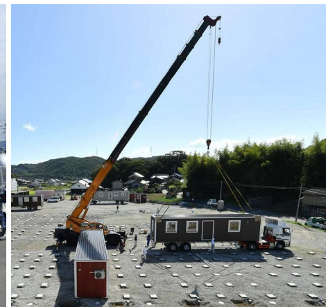
7月豪雨災害 モバイルハウス仮設住宅
