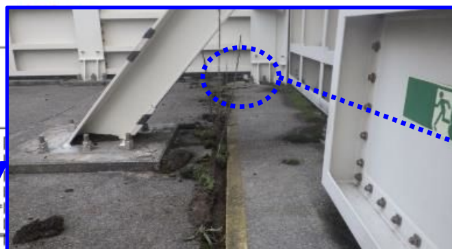
1号機 放水槽防潮壁 (内側)
