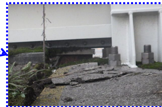
1号機 放水槽及び1号機 補機冷却排水連絡槽防潮壁の基礎の沈下 概要図
