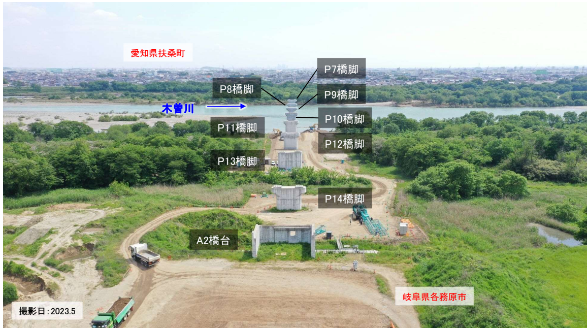
下部工はP7～P14橋脚及びA2橋台を施工済み
