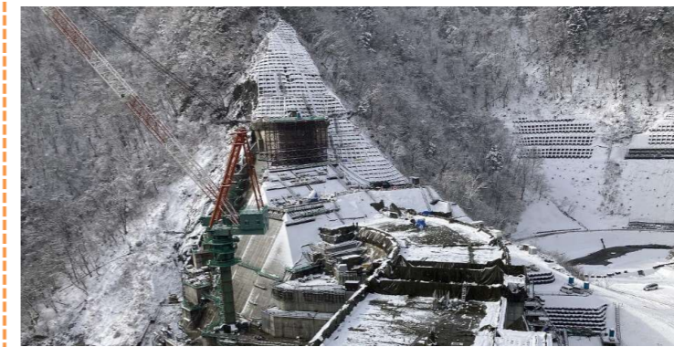
堤体左岸から撮影(越冬養生)
