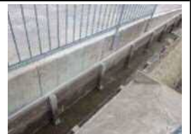
施工前後 間詰めコンクリートで隙間をなくす。
