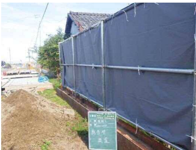
防音壁設置状況
