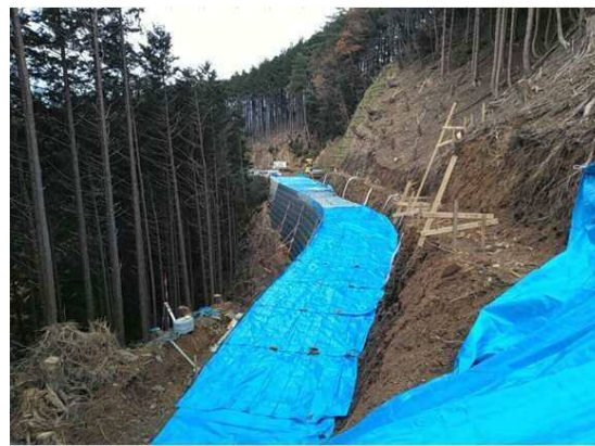
補強土壁盛土部シート養生
