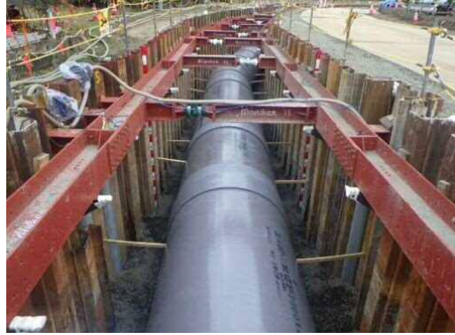
<管路敷設完了時(埋戻前)>
