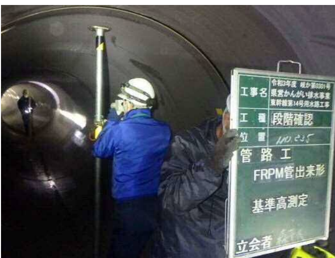
管内で基準高を確認する工夫
