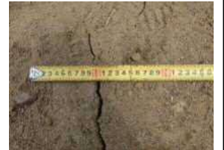
下水道変位計測状況
