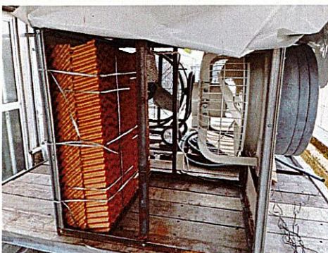
冷却パッドを2重にすることで冷却効率向上
