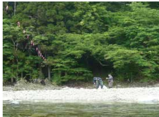
防鳥糸設置作業の様子 (益田川漁業協同組合 下呂市)
