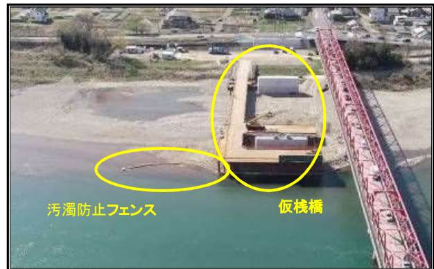
仮棧橋、汚濁防止フェンスの設置状況
