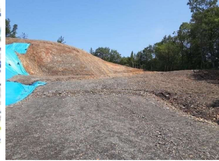
写真②: 滝呂バイパス(終点: 多治見市滝呂町側)
