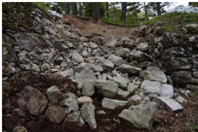
出柵形虎口 破城の状況
