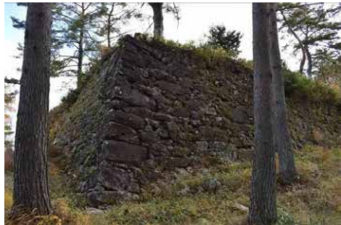
本丸外曲輪石垣 西南隅
