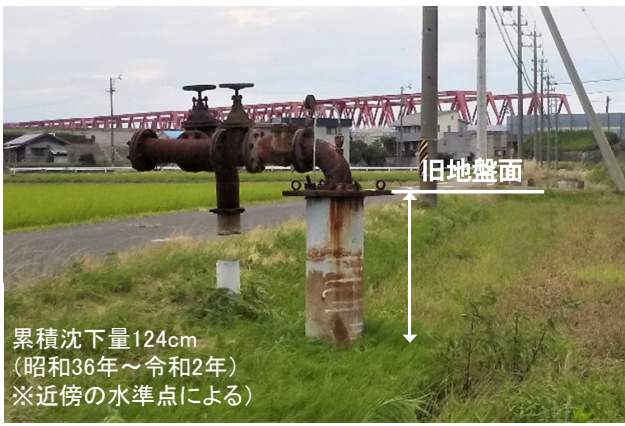
累積沈下量124cm (昭和36年～令和2年) ※近傍の水準点による
