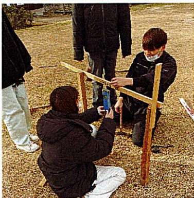
測量実習・丁張設置
