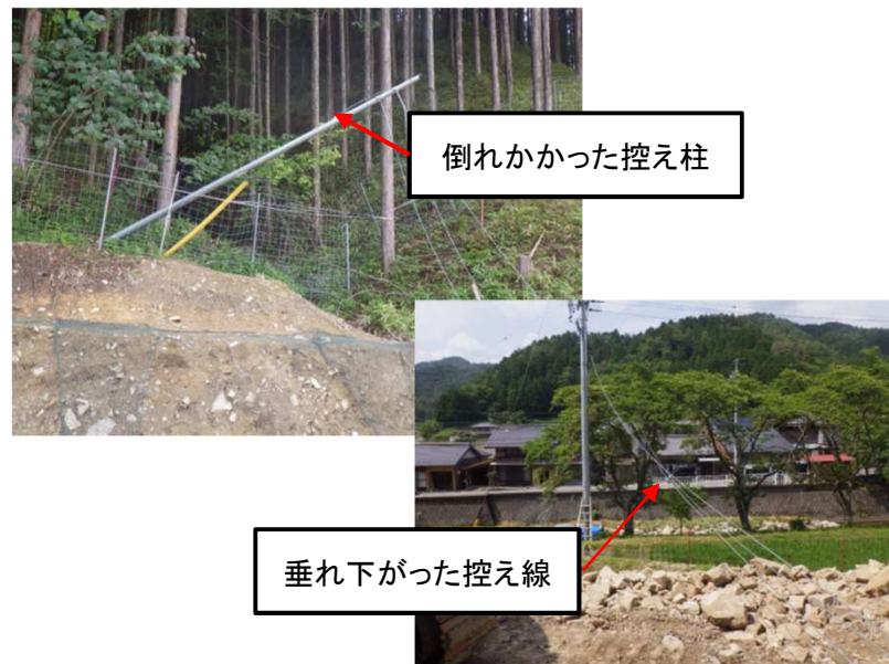
事故現場状況写真
