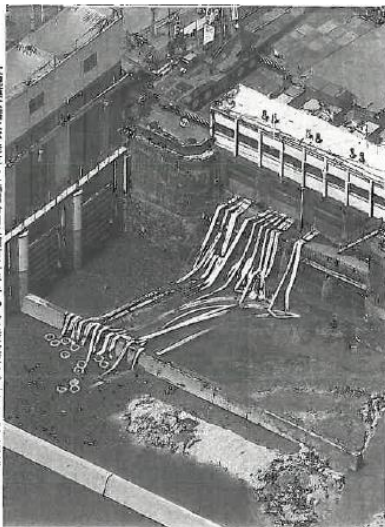
明治用水頭首工の漏水状況(イメージ)
