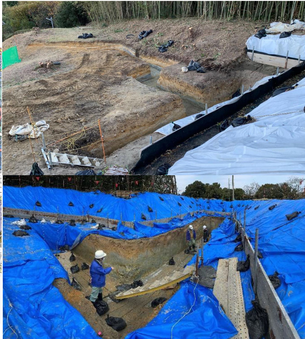
トレンチ調査状況（BF4地点付近）
