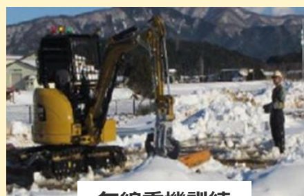
無線重機訓練
