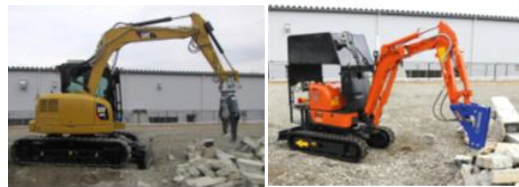
小型・大型無線重機 (屋外の瓦礫等の除去)
