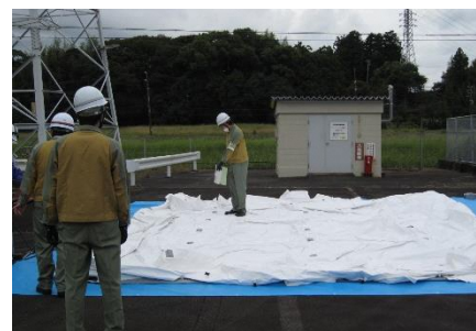
拠点の設営作業
