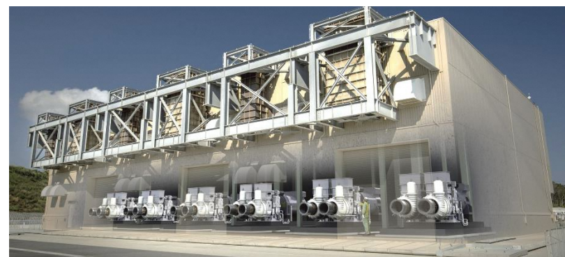
緊急時ガスタービン発電機
