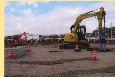
無線重機によるガレキ処理
