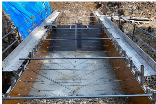
治山事業における合板型枠
