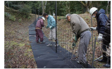
鳥獣防護柵設置状況
