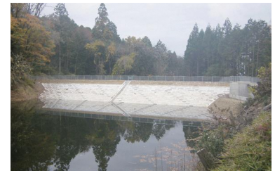
改修後のため池（瑞浪1期地区 大洞ため池）
