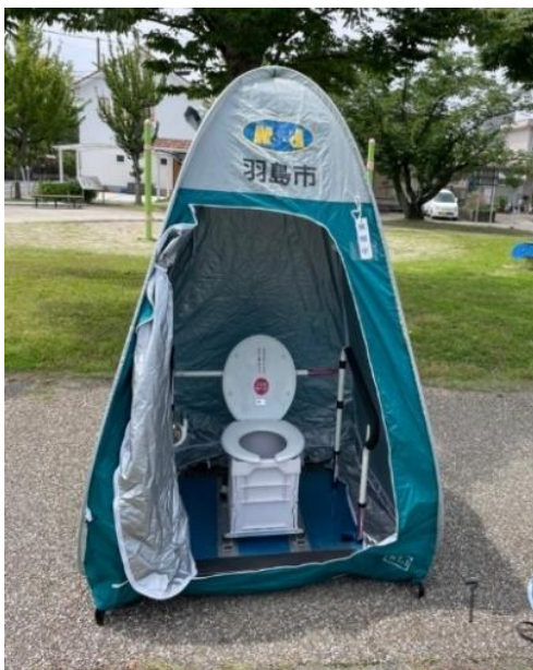
マンホール直結型簡易トイレの整備 (2021年)
