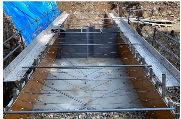
治山事業における合板型枠
