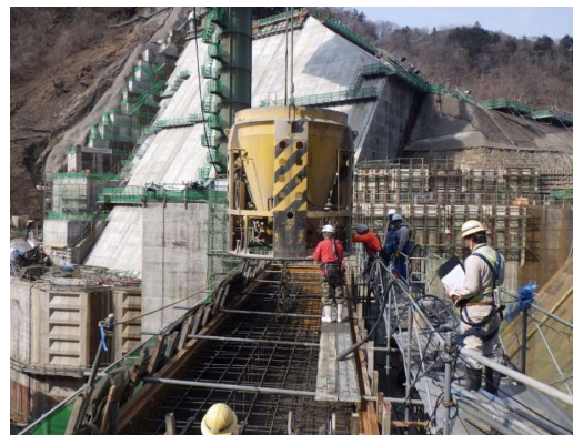
堤体導流壁打設(EL519.00)
