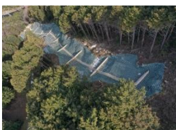
揖斐川町瑞岩寺足打谷 山腹工
