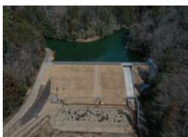
ため池の耐震・豪雨対策
