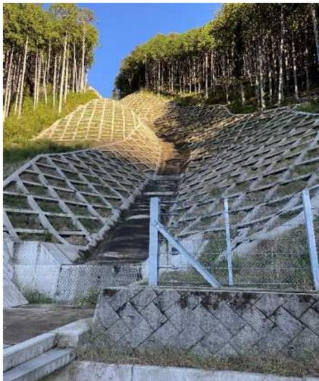
目に見える範囲に施工されているのが流路工と斜面を保護する法枠工で、さらに上方にも治山ダムや法枠工が施工されており、この箇所全体の工事費は約5.5億円である。
