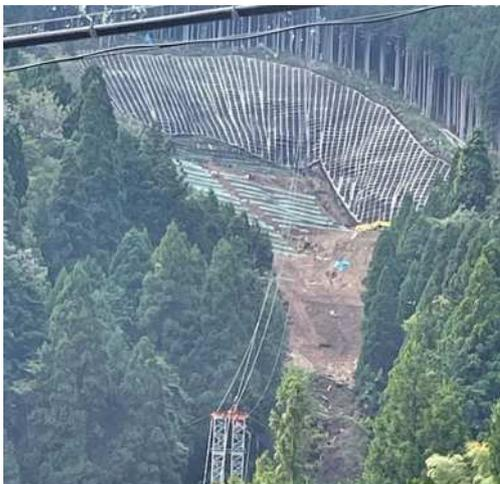
平成 30 年 7 月豪雨及び令和 2 年 7 月豪雨に伴う降雨により土石流が発生したが、いずれも砂防堰堤が土砂・流木を捕捉し、下流域への被害を防止した。
