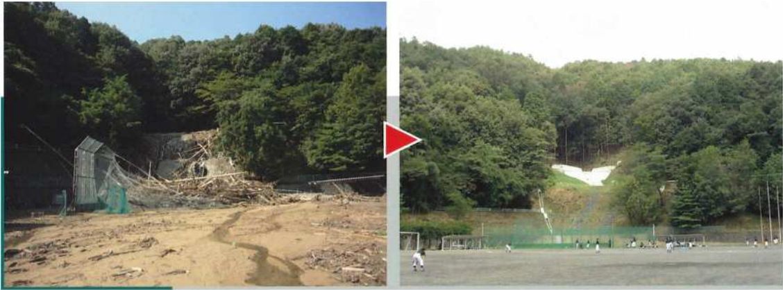
【パンフレット 「岐阜県の治山」より】
