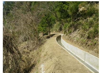
更新した農業用水路 (高山市 東高山地区 塩屋日面用水)
