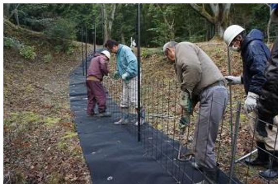
鳥獣防護柵設置状況
