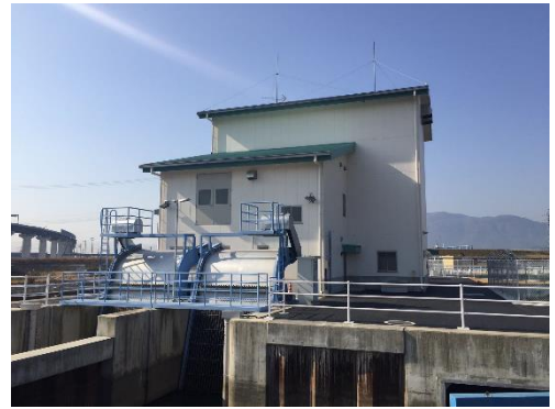
更新した排水機場(大垣市 静里地区 静里排水機場)
