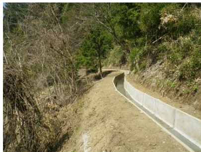
更新した農業用水路 (高山市 東高山地区 塩屋日面用水)
