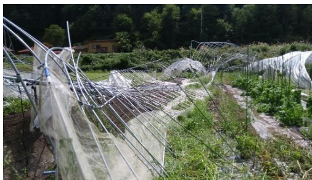
風水害によるパイプハウスの倒壊
