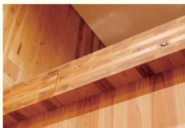
※ CLT (Cross Laminated Timber) ひき板（ラミナ）を並べた後、木の繊維方向が直交するように積層接着した木質系材料
