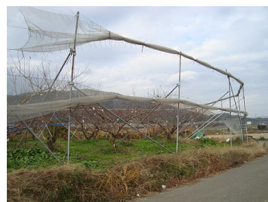
写真1 防風ネットの巻き上げの様子
