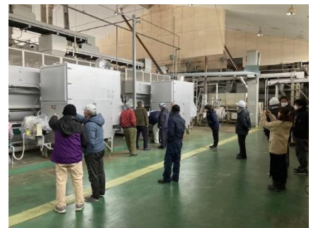
【粗揉機熱交換機の試運転】
