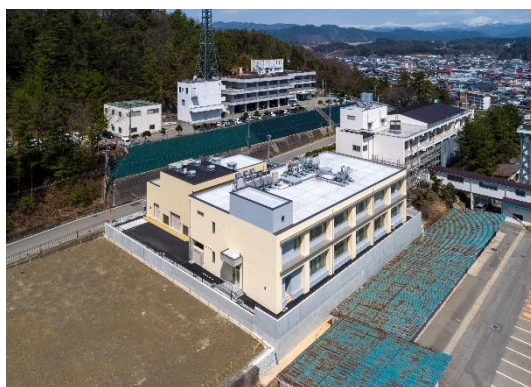
<飛騨家畜保健衛生所外観>
