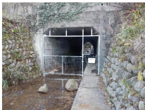
<拡散防止柵の整備>
