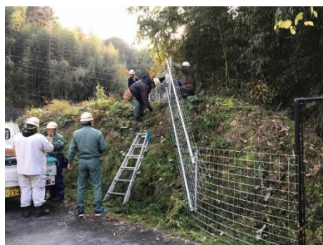
<防止柵の設置作業>
