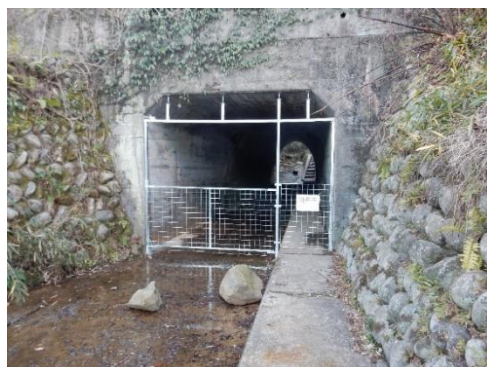
<拡散防止柵の整備>
