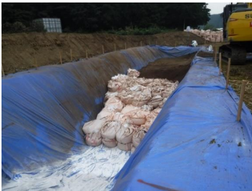
<フレコン投入・埋め戻し>
