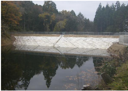
改修したため池(瑞浪市 瑞浪1期地区 大洞ため池)
