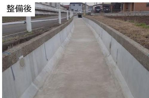
農業用水路の予防保全対策 (関市 曾代用水四期地区 曾代用水)
