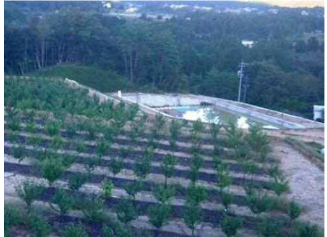
上流から沈砂池を望む
