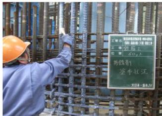
②コンクリート打設前に次工程である鉄筋継手箇所に土嚢袋を被せ、コンクリートの付着を防いだことにより、鉄筋継手施工での品質の確保を図った。
