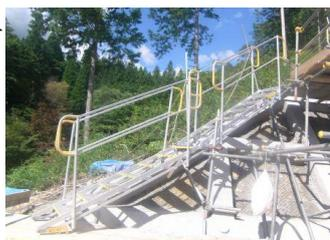
②支保工盤台の外周にネットを配置し、転落、落下物防止対策を実施することで安全性の向上を図った。
