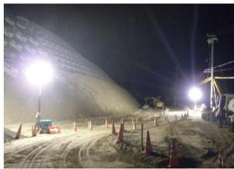
②隣接する他工事により工事車両等の増加が予想されたため、ガードレール外側の法面に歩行者用の仮栈橋を設置し、工事の進捗に応じて栈橋の位置を変更しながら、歩行者の安全を確保した。
