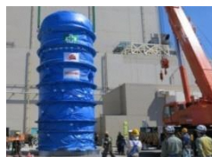
ⓓフィルタバント設備（設置前）
