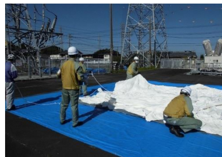
拠点の設営作業
