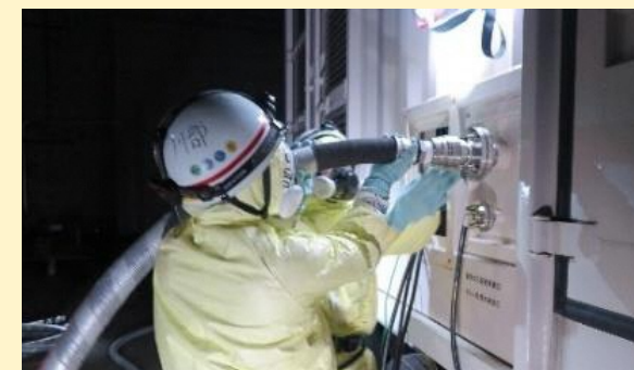
タイベックスーツを着用した夜間訓練（窒素供給車両への電源接続）
