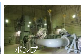
ⓑ緊急時海水取水設備
