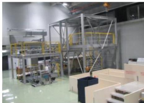
事務所棟 訓練施設
