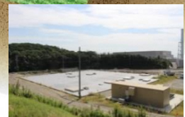
Ⓜ緊急時淡水貯槽
