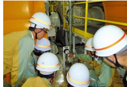
若年者火力研修 (稼働中の設備の特徴・注意点を確認)
