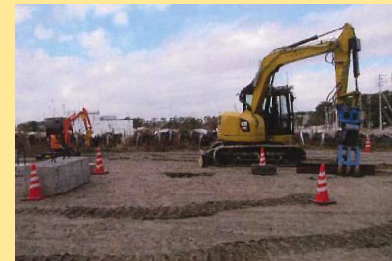
無線重機によるガレキ処理
