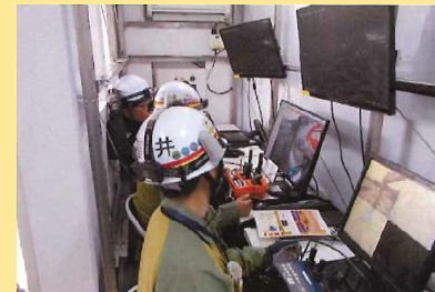
無線重機操作室
