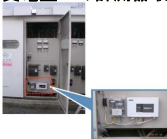
受電盤への計測器取付例
