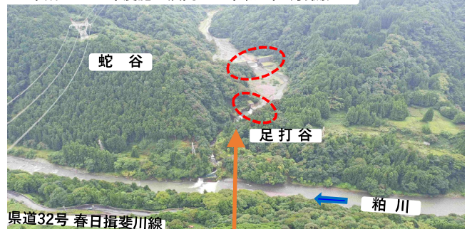
平成18~23年度施工溪間工 令和4年7月撮影
