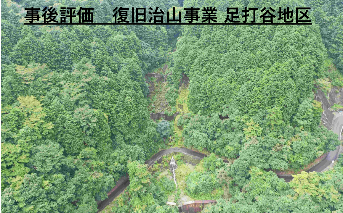
足打谷右岸支流・平成19・27年度施工溪間工 令和4年7月撮影
