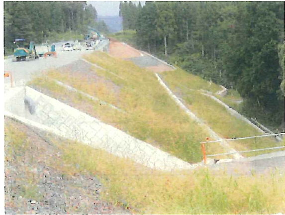
盛土法面の緑化状況
