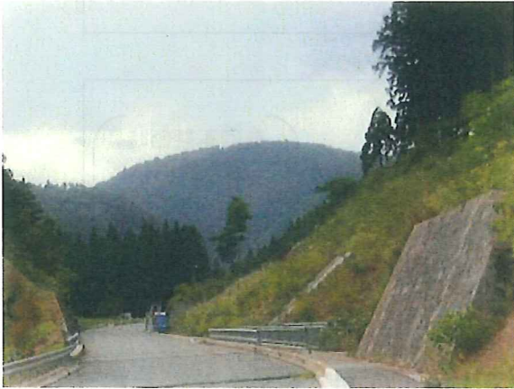
切土法面の緑化状況
