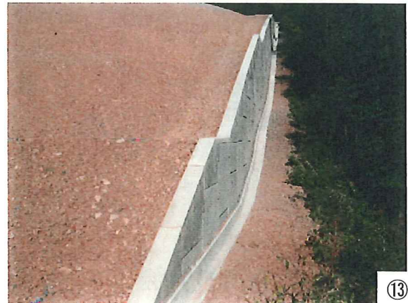
補強土壁 (テールアルメ)
