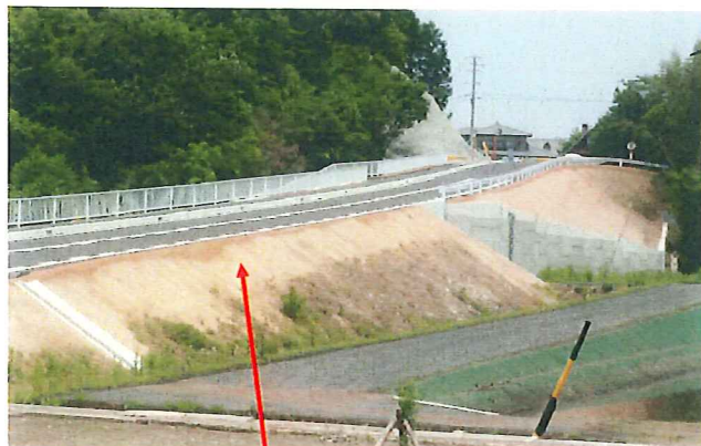
流用土による盛土
