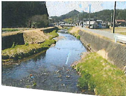
既設護岸の状況
