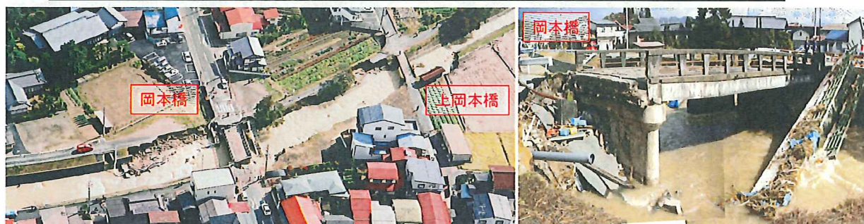
▲平成16年10月出水による被災状況
