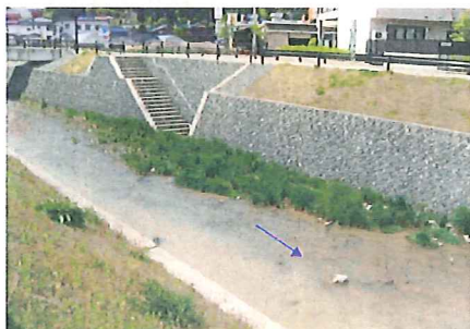
上岡本橋下流 (階段を設置し親水性に配慮)
