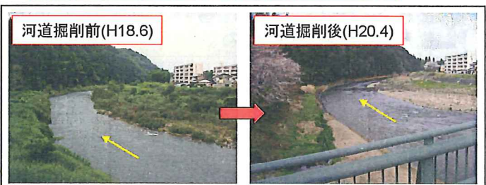
津保川(10.0k付近) 田富橋下流の河道掘削
