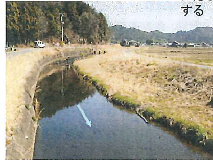
既設護岸の状況
