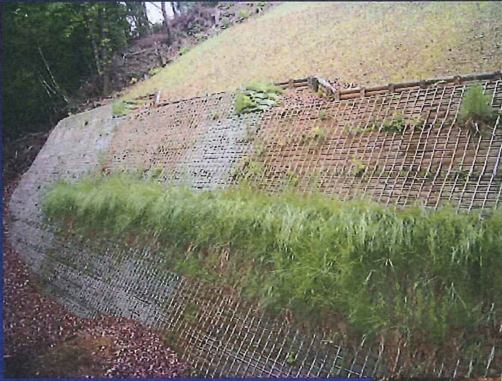
残土処理費縮減のため 補強土壁工を採用
