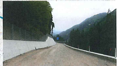
坑口周辺から終点側を望む(明宝側)
