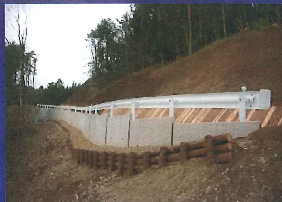
上:県リサイクル認定製品を使用したL型擁壁
