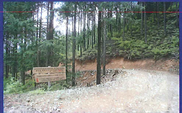
開設された作業道
