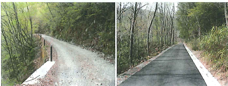
下方道改良状況
