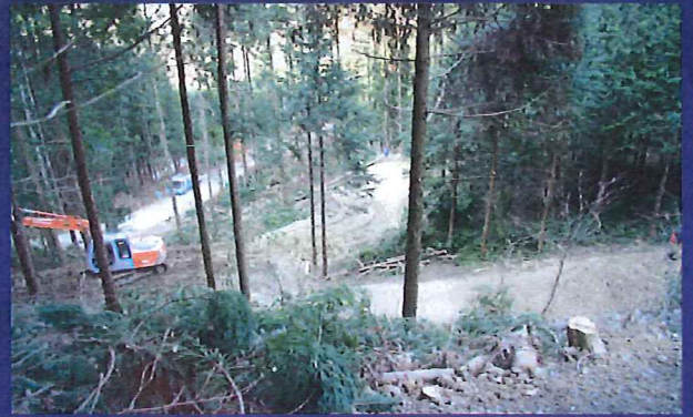
林道沿線における作業道開設工事
