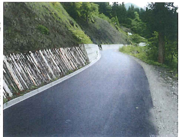
整備した林道状況
