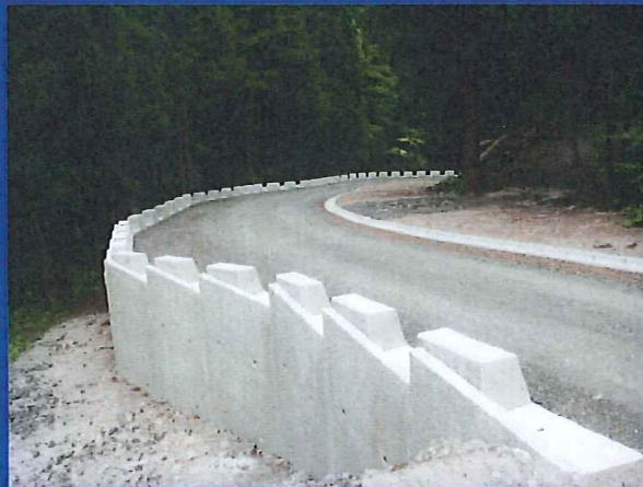
プレキャストL型擁壁工
