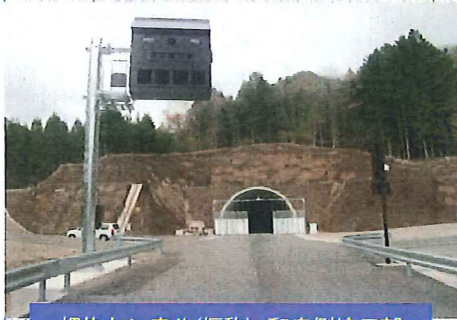
畑佐トンネル(仮称) 和良側坑口部
