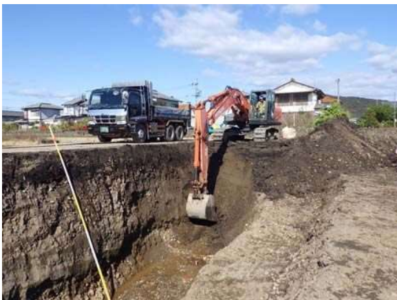
河川土工施工状況
