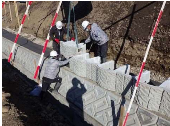
護岸工施工状況
