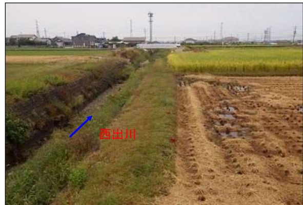
施工前の状況
