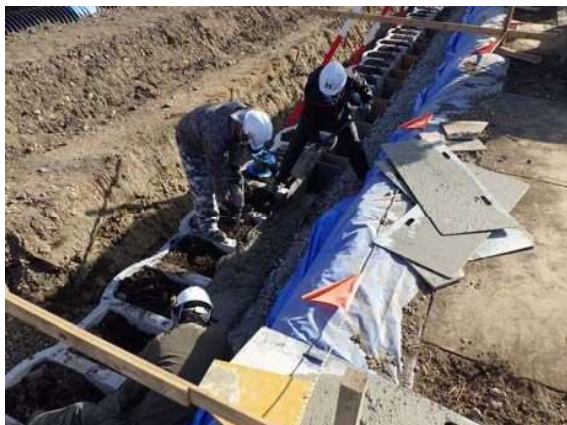
護岸工施工状況
